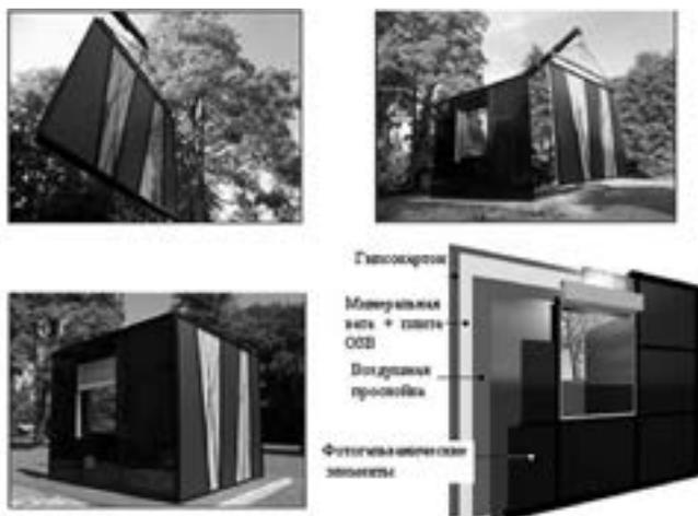
Рис. 3. Быстровозводимые здания с фотогальваническими модулями Faceactive.
