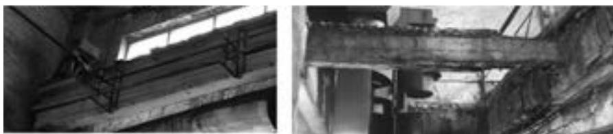
Рис. 1. Повреждения в железобетонных балках
