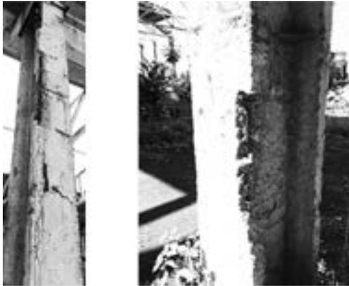
Рис. 1. Повреждение двутавровых колонн в процессе эксплуатации.
